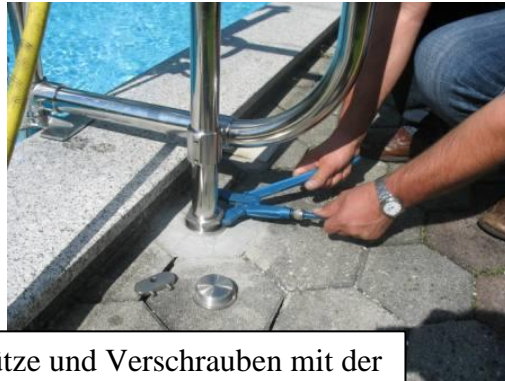
Platzieren des Poolliftes am Poolrand
