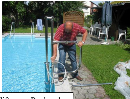
Platzieren des Poolliftes am Poolrand
