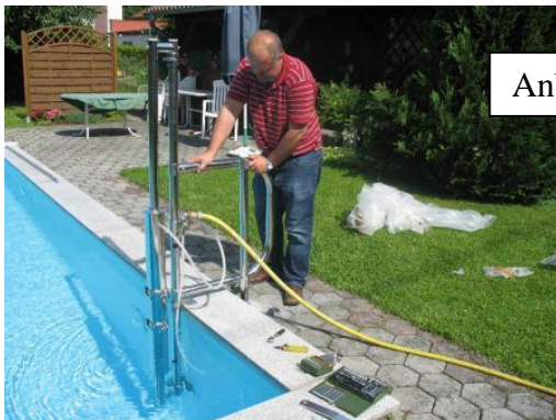
Einführen der zusätzlichen Stütze und Verschrauben mit der Überwurfmutter an der Konsole
