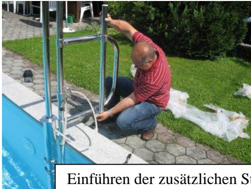
Platzieren des Poolliftes am Poolrand
