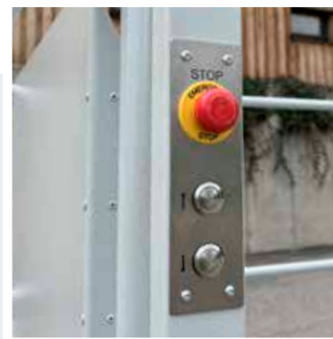
Steuerung der Hebebühne inklusive Stop-Taste
